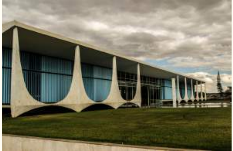
The roof of Palácio da Alvorada
